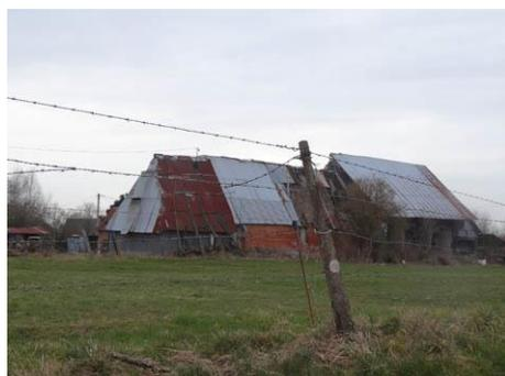
Attention toutefois à ce que l'usage de la tôle ne conduise pas à abandonner les bâtiments à leur déchéance. Car la pérennité de la tôle n'est que de quelques dizaines d'années notamment aux zones de frottement ou aux percements permettant de les fixer car la rouille trouve alors des terrains de développement intéressants. Les propriétaires les laissent se dégrader, progressivement la tôle n'assure plus son rôle d'étanchéité.
